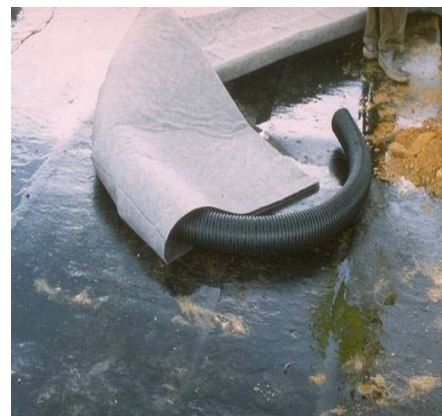
Utilizare teava drenaj cu Enkadrain® Findrain
