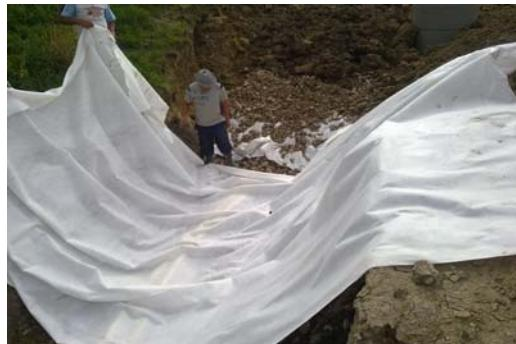
**1. In santul sapat se asterne geotextilul netesut avind grija sa nu se deterioreze, taia geotextilul pt a nu intra ulterior pamint.**
