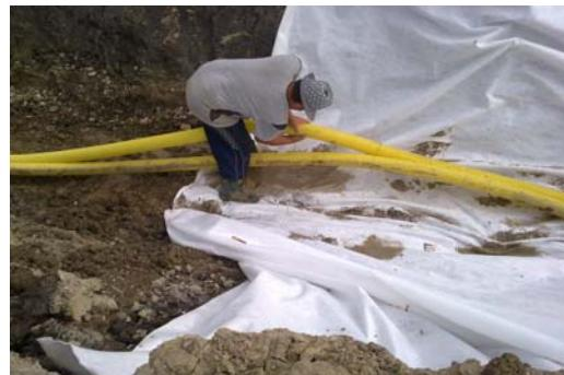
**2. Peste geotextilul asternut se pune teava de drenaj, iar in functie de apele subterane se poate pune una sau doua tevi paralel.**
