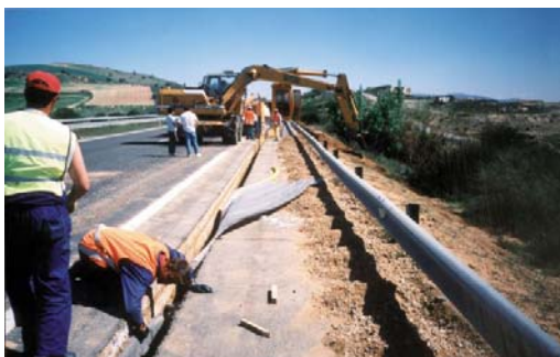
Drenaj marginal al autostrazii in Spania
